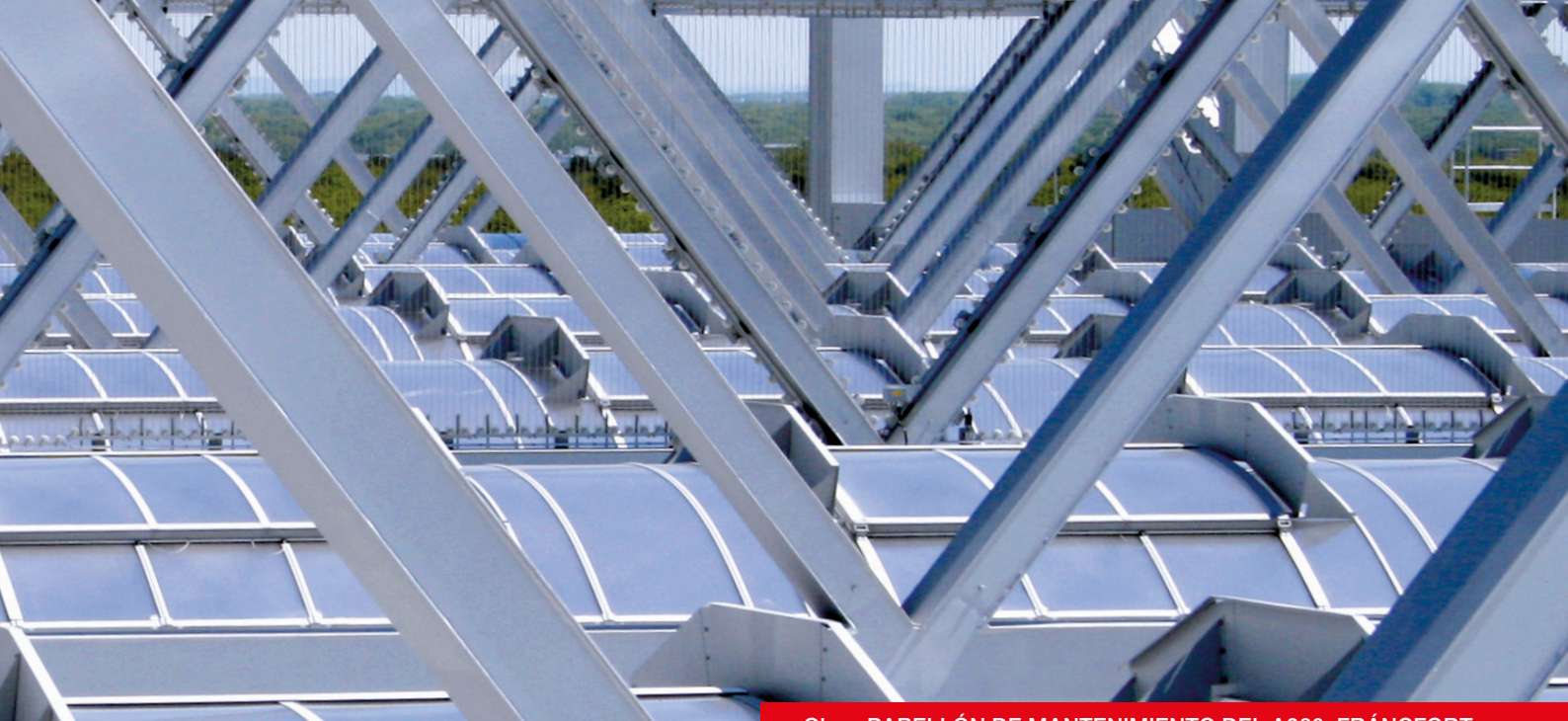
Obra: PABELLÓN DE MANTENIMIENTO DEL A380, FRÁNCFORT
